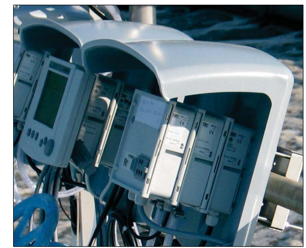
B STACKED MODULES - XYLEM IQSN I-103 SCALE: NTS
