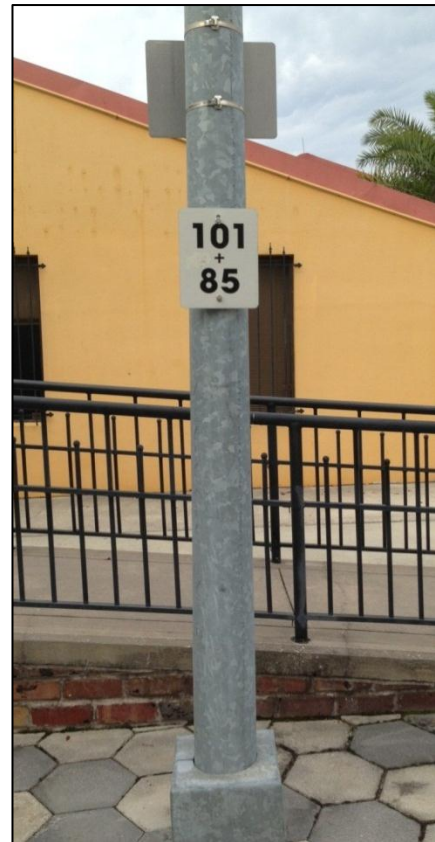
PHOTO 21 MISLABELED OCS POLE
